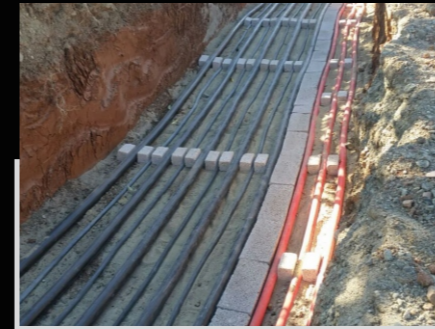
Kablo Serim ve Çekim Çalışması
