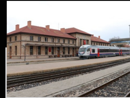
Kontrol Binaları Yapımı
