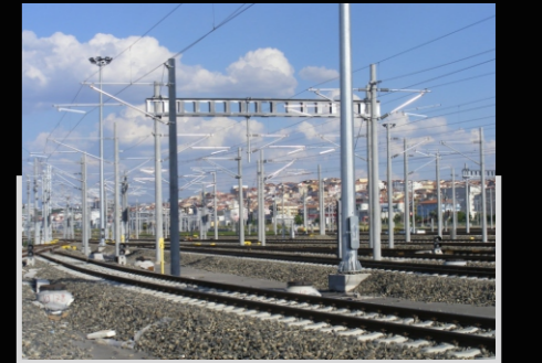
Katener Direkleri ve Ankraj Temeli Beton Yapı İmalat ve Montaj Çalışması
