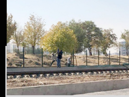
Beton Duvar Üzerine İHATA Duvar Yapımı
