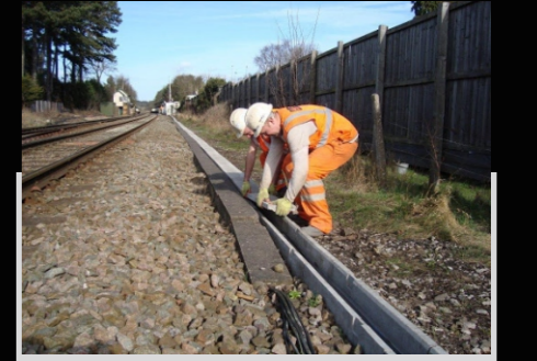
Kablo Kanalet Yapım ve Uygulaması
