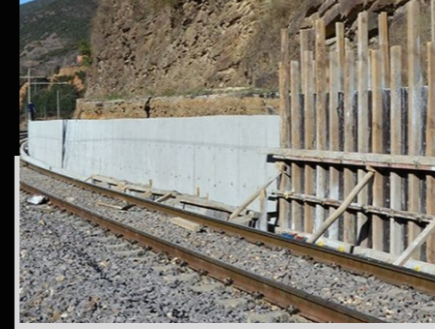
Saha Betonu ve İstinat Duvarı
